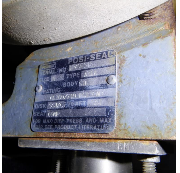
Inlet ESD valve body tag.
